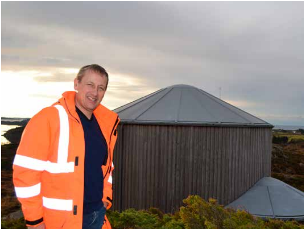
Bømlo Vatn og Avløp har bygd til sammen 11 høydebasseng – alle modernisert. Driftssjef Odd Petter Habbestad viser høydebasseng på Heimstafjellet 65 m over havet på Halleråker som var ferdig i 2007. Foto: Kjell Jacobsen
