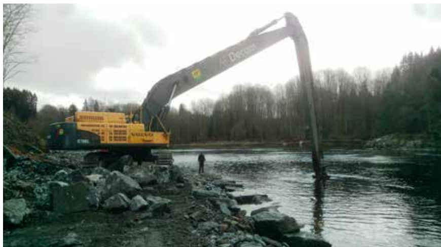
70 tonns graver med 24 m lang stikke ble benyttet i det vanskelige arbeidet med å plastre fyllingen på 5 m dyp 11 m horisontalt ut fra elvebredden. Foto: Martin Brathagen
