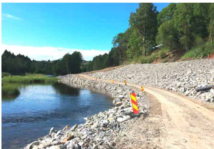
Bildet viser fyllingsmasser langs skråningen med anleggsveg i bunnen. Foto: Larvik kommune.
