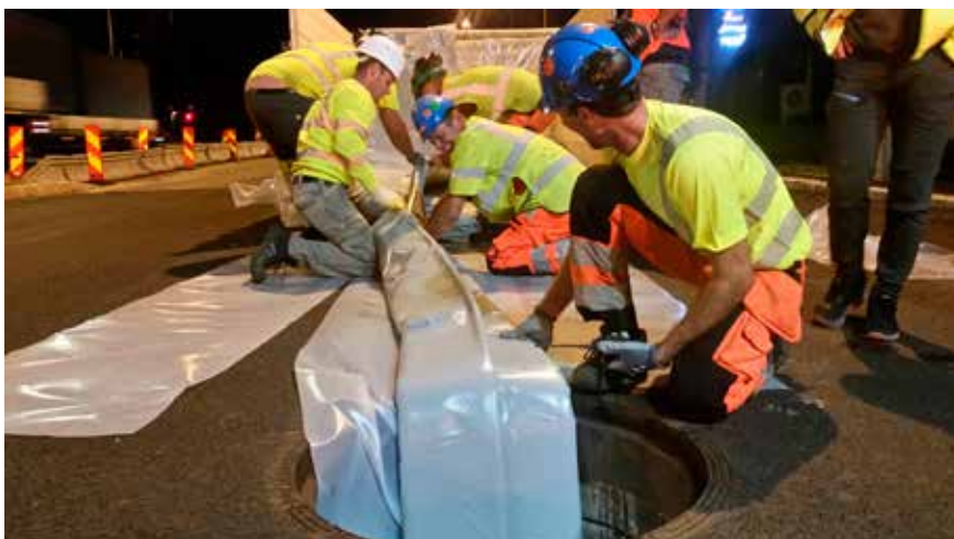
Første installasjon forberedes. Foto: Martina Bergh Svedahl
