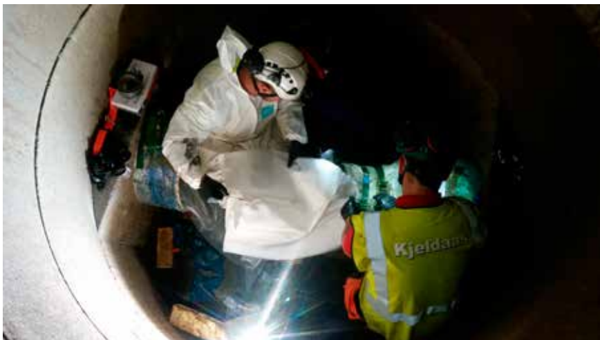
I løpet av fire netter ble det installert totalt 850 meter strømpe, hvorav den lengste strekningen var på 265 meter. Foto: Martina Bergh Svedahl
