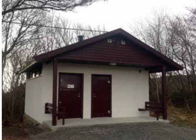
Nyåpnet toalettbygg langs kyststien på det statlig sikrede friluftslivsområdet på Vestre Rakke.
