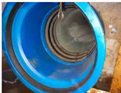
Slik så overgangen fra strømpeføring til armatur ut. Foto Kjeldaas AS
