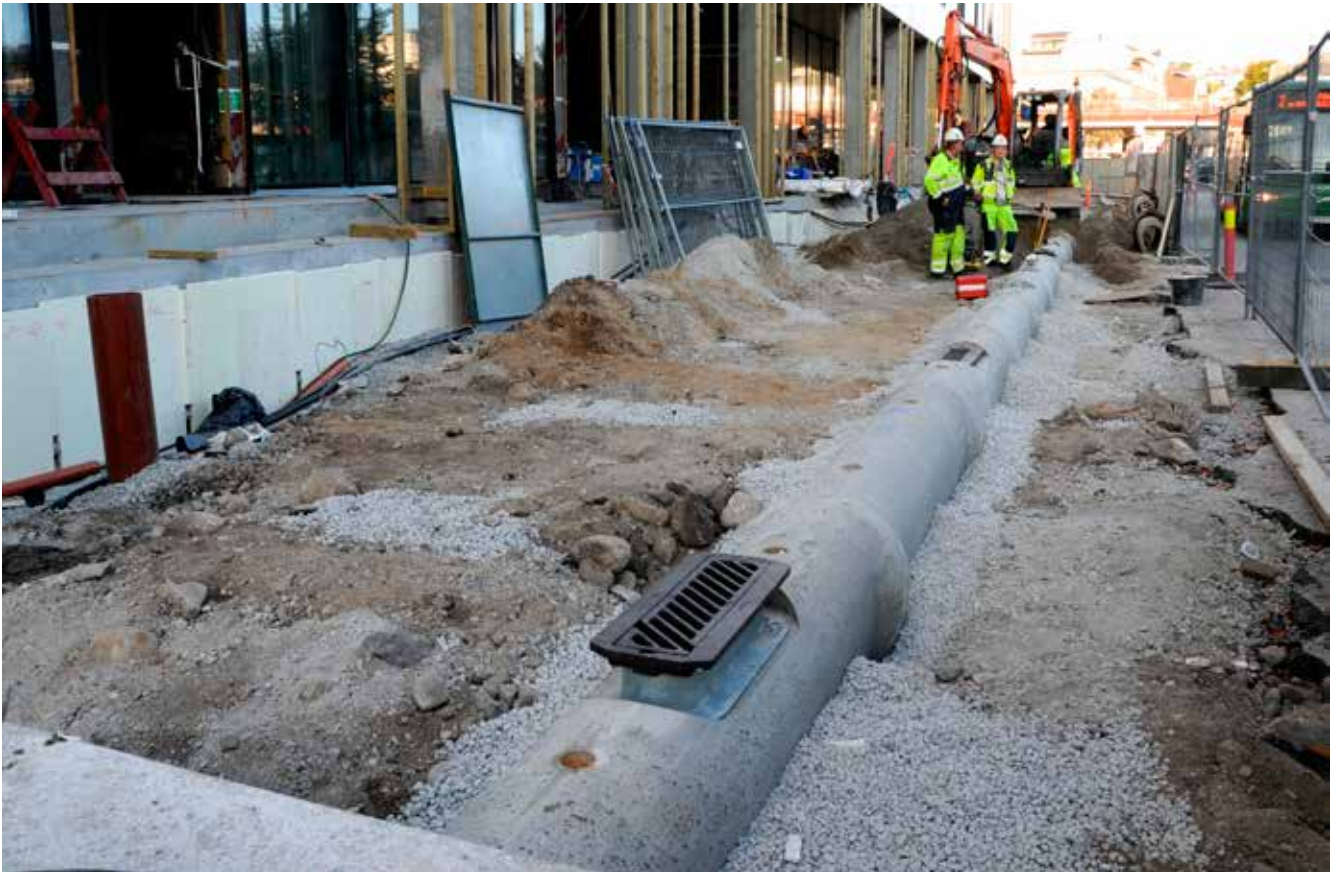
I september 2014 ble de første Qmax Storm-rørene lagt i Julie Eges gate. Foto: Inger Anita Merskedal
