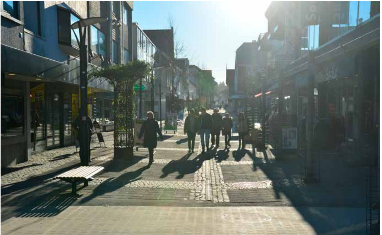
Langgata skal bygges om for å tåle større regnvannmengder, både under gata og i en sterkere V-form av gatetverrsnittet. Foto: Christen Ræstad
