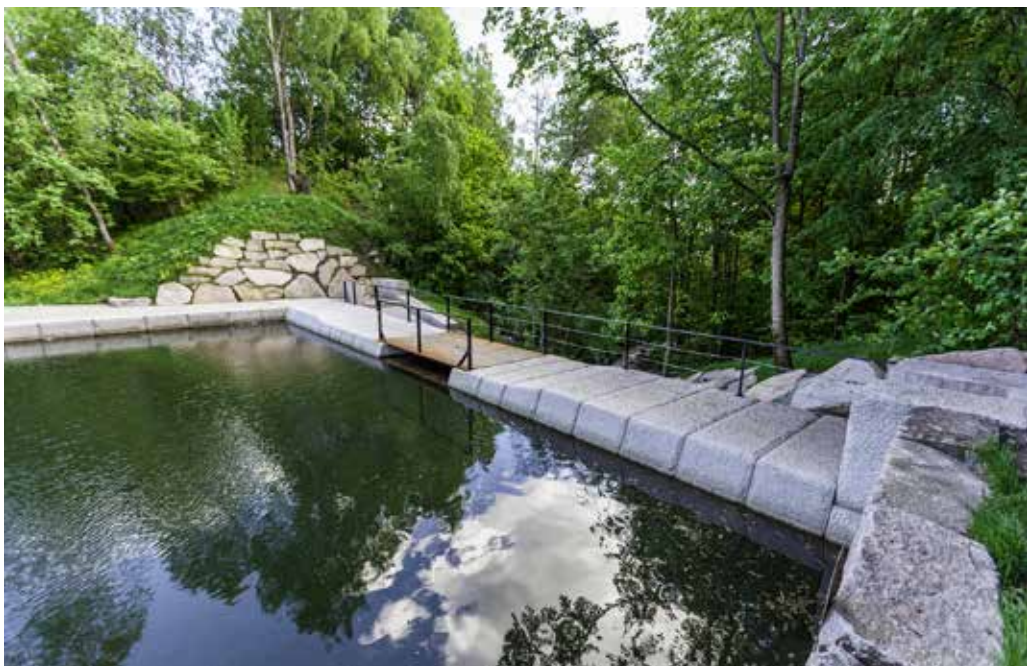
Damkrone og utløp fra Groruddammen. Foto: Thomaz Majewski for LINK landskap
