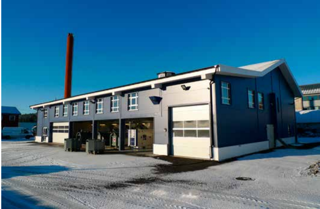
Den nye varmesentralen Drømtorp 2.
