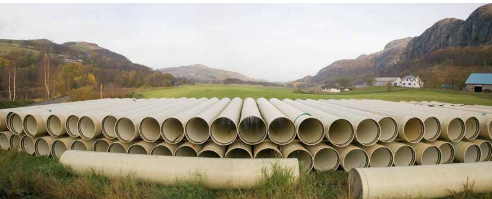
Ikke-korrosive materialer benyttes i økende grad i vannforsyningsprosjekter og scorer godt på miljø- og levetidsbetraktninger.
