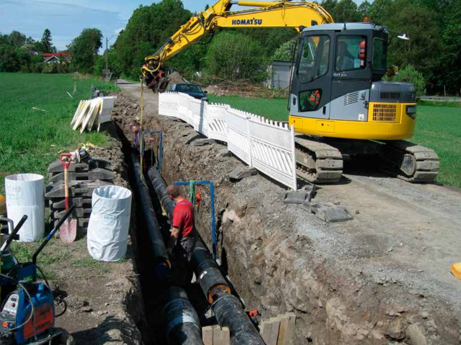
Legging av rør mot Næringsområdet på Drømtorp.
