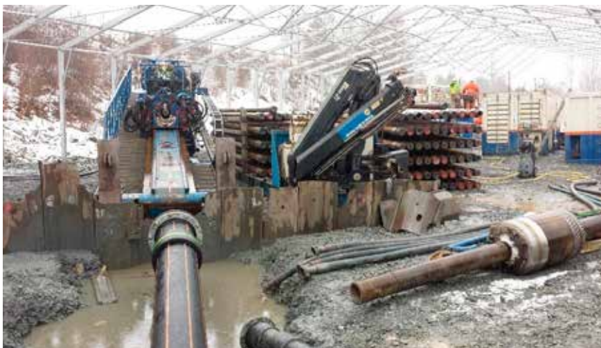
Det 1.285 meter lange PE-røret er trukket frem til boreriggen etter 6 ½ time. Borerigg, blandedanlegg for borvæske, håndtering av borstenger og øvrig utstyr har i anleggsperioden vært beskyttet av et oppvarmet telt på 20 x 60 meter (Foto: Hendrik Panman).
