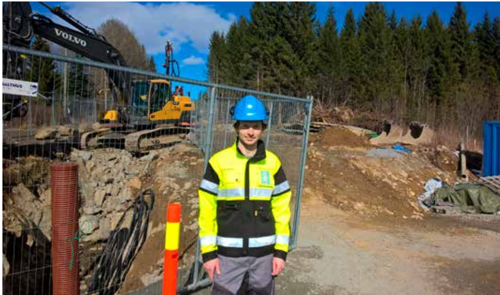
Tellef ute på prosjekt/befaring
