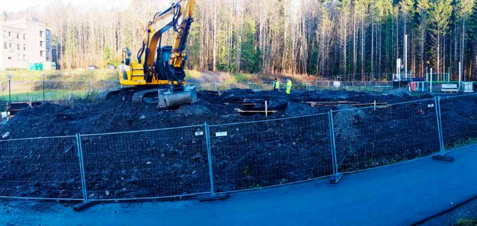
Nesøya treningspark (anleggsfasen)
