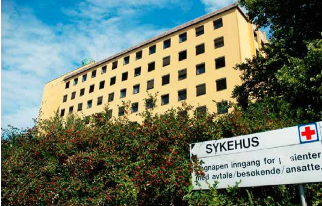
Kan dette bygget, uten videre, brukes til bolig?
