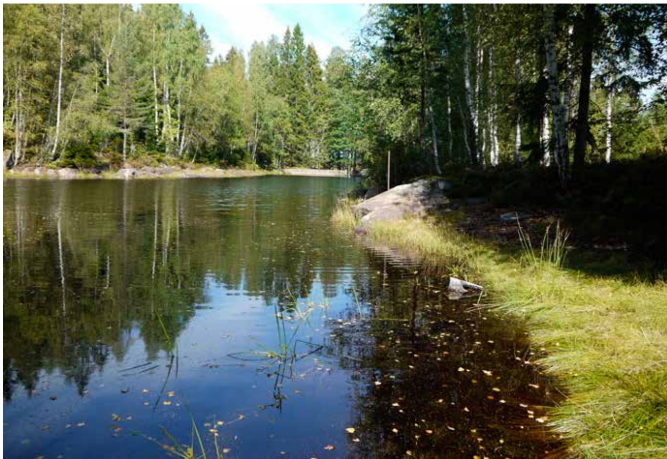
Øvre Askdam ble tidligere brukt til drikkevann for innbyggere i Gjerdrum. Nå er dammen revet, og området føres tilbake til sånn det var før dammen ble bygget.
