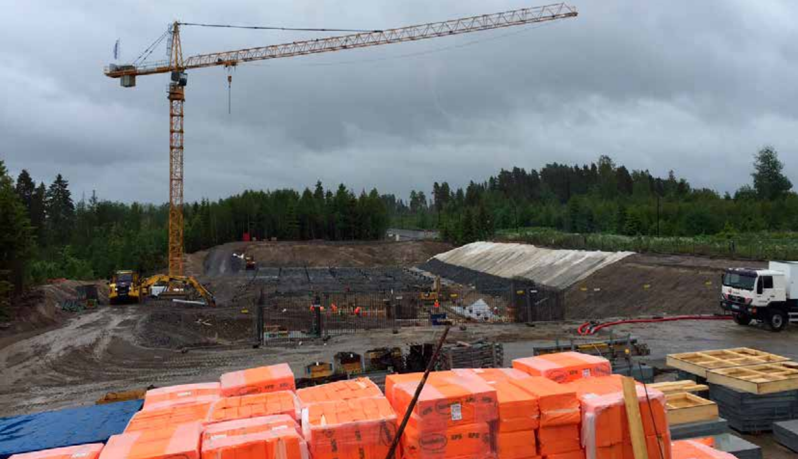
Bygging av MIRA IKS avløpsrensseanlegg på Tangen.
