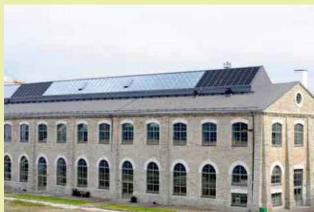
Noen av bygningene i industriområdet er verdt å ta vare på. Dette er den første som er ferdig pusset opp.
