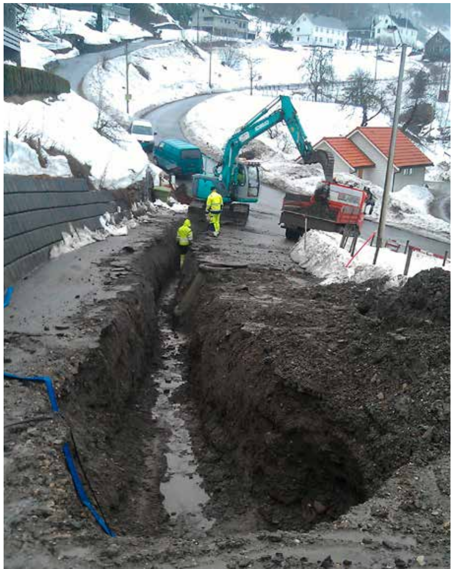
Sanering vasslekkasje
