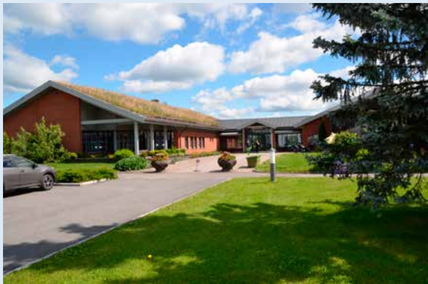
Administrasjonsbygget til NRVA i Strandveien 22 på Strømmen. Foto: Odd Borgestrand
