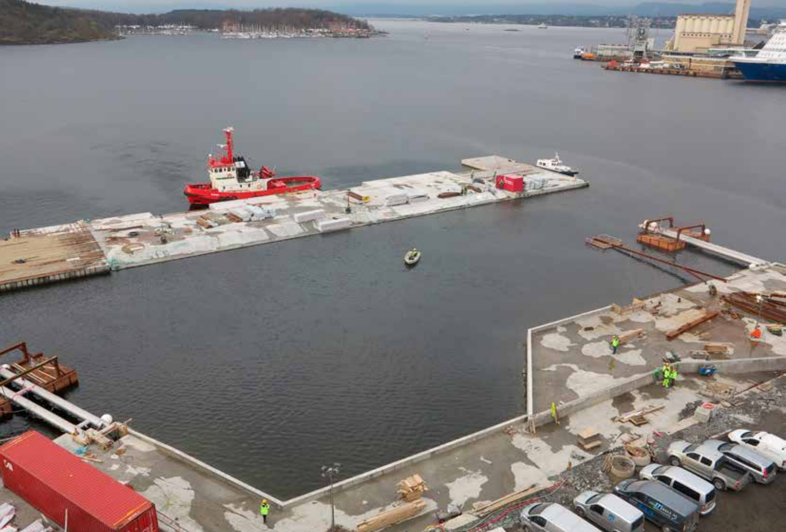
Sørenga badepark under bygging.
